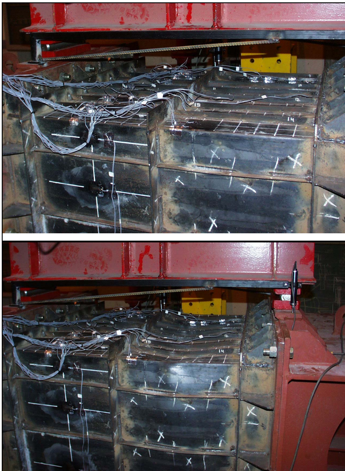
Figura 262 Evolução da deformada dos painéis superior e lateral com o aumento do carregamento. Em cima nota-se o início de instabilidade da placa e reforço do painel lateral. Em baixo já se deu o colapso da viga caixão.
